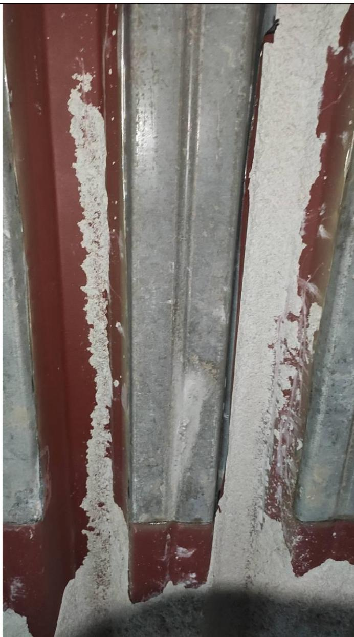
**Фото фрагмента вскрытия несъемной опалубки потолочного перекрытия**
