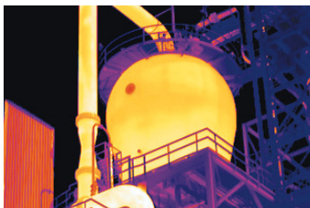
Проверка огнеупорной изоляции на нефтехимическом реакторе
