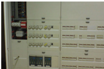
Нагрузка в блоках предохранителей распределяется неравномерно
