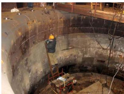
Оценка монолитности системы «металлическая камера рабочего колеса-бетонный массив»
