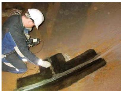
Проведение УЗК сварных швов на горизонтальном участке водовода Саяно-Шушенской ГЭС дефектоскопом А1212 МАСТЕР
