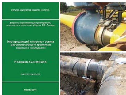
Рис. 5. Неразрушающий контроль качества сварных соединений тройников сварных с накладками
