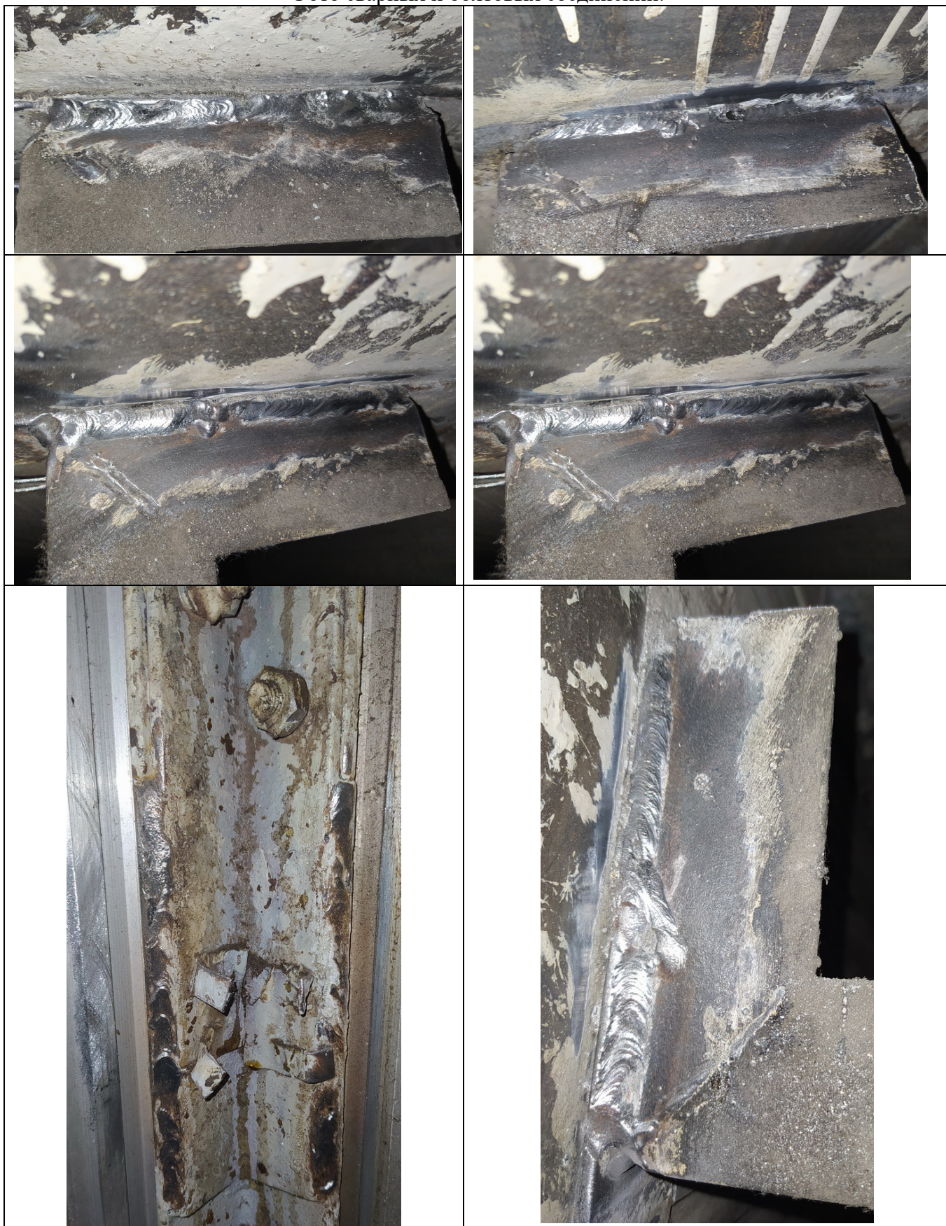
Фото сварных и болтовых соединений.
