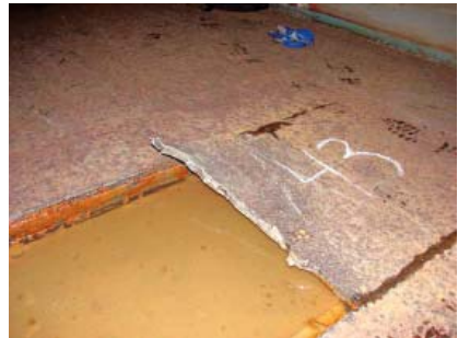
Рис. 4. Срыв участка облицовки водосброса (Саяно-Шушенская ГЭС)
