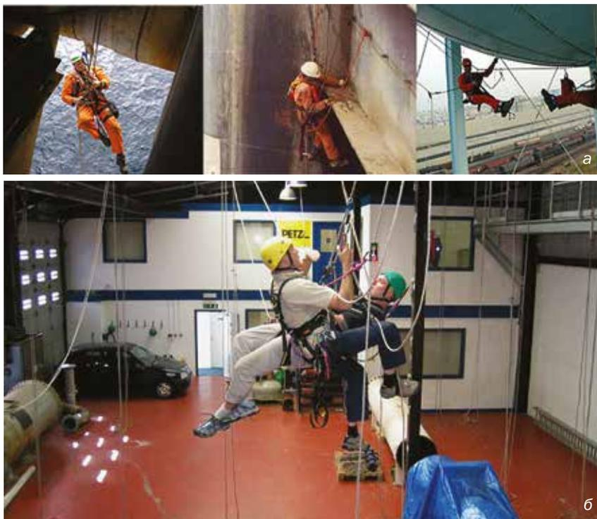
Рис. 1. Типичные условия выполнения УЗК на объектах нефте- и газодобычи и переработки (а) и соответствующая подготовка операторов в одной из школ НК (б)
