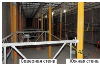
Рис. 1. Общий вид туннеля в Медицинском центре Университета в Монреале
