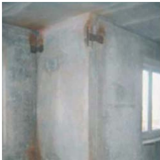
Рис. 6. Пониженная температура в верхней части стыка стеновых панелей
