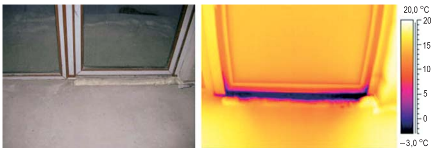
Рис. 4. Порог двери является «мостиком холода»
