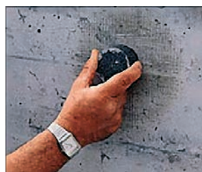
Рис. 4.9.16 Предварительная очистка поверхности с использованием шлифовального камня
