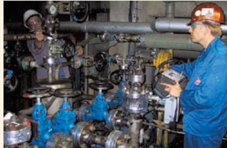
Рис. 7. Проверка на герметичность с помощью водородного течеискателя
