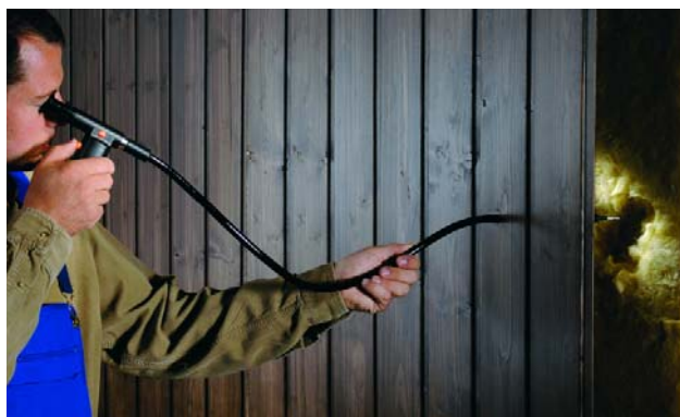
Проверка изоляции с использованием жесткой трубки
